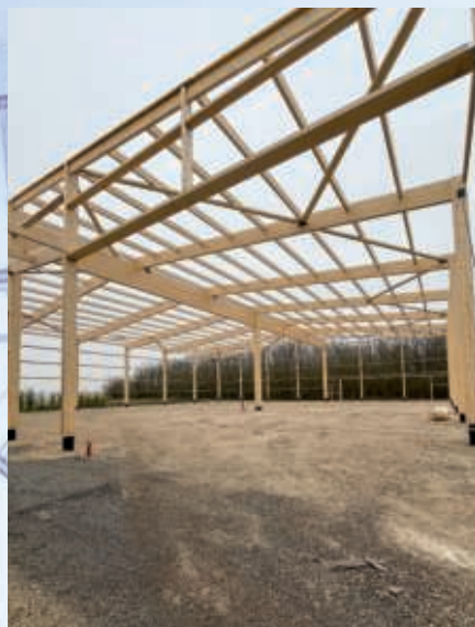
Mise en place de la structure bois pour la couverture du « pôle raquette ».
