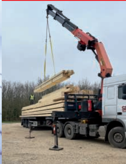
Mise en place de la structure bois pour la couverture du « pôle raquette ».
