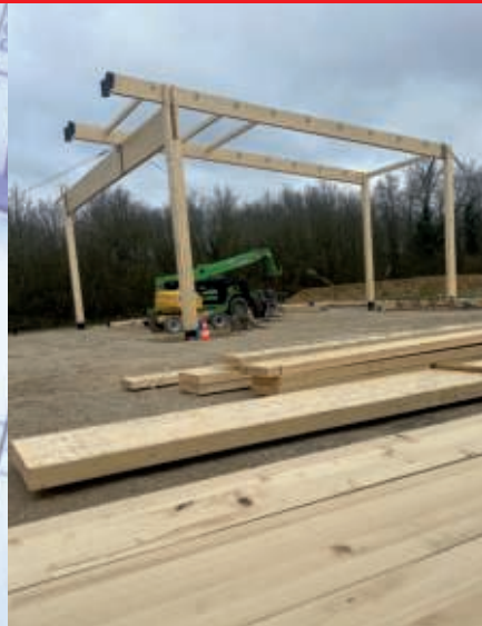
Mise en place de la structure bois pour la couverture du « pôle raquette ».
