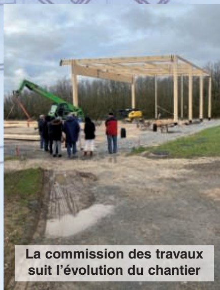
Mise en place de la structure bois pour la couverture du « pôle raquette ».
