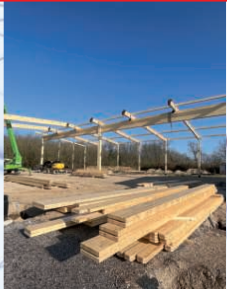
Mise en place de la structure bois pour la couverture du « pôle raquette ».
