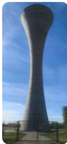
Château d'eau de Brissard Abondant
