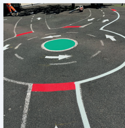
Réfection peinture-marquage de la cour école maternelle
