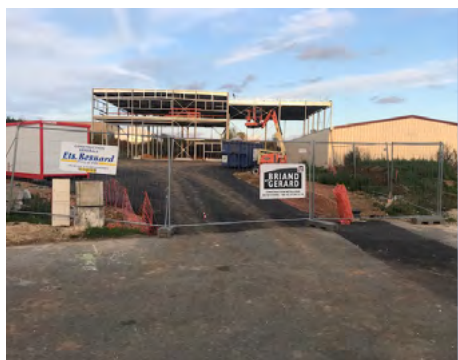
Construction zone des forts
