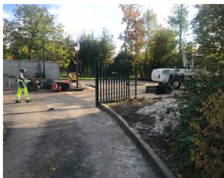
Travaux extension plate-forme de l'atelier, réalisé par TP 28
